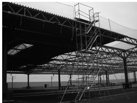
Obr. 13: Volně stojící schodišťová věž
