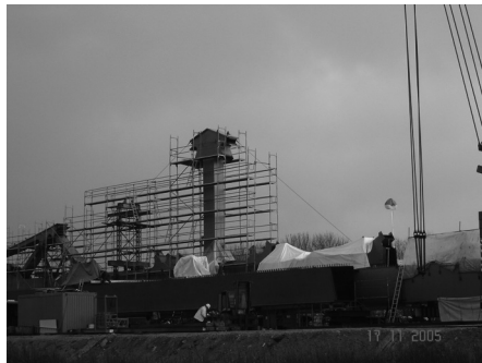
Obr. 4: Pracovní a zabezpečovací konstrukce
