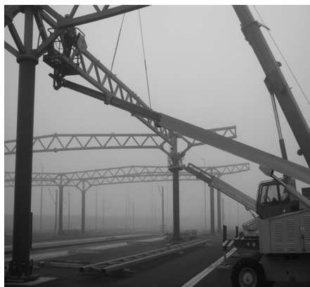
Obr. 9: Konstrukce je smontována na terénu a poté osazena v potřebné úrovni
